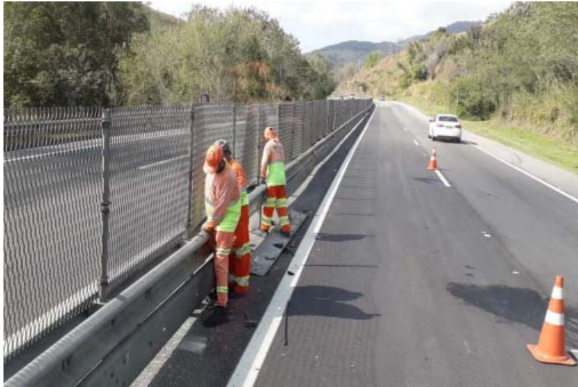
Foto 3 – Manutenção de Dispositivo de Segurança – Km 15+000 Norte
