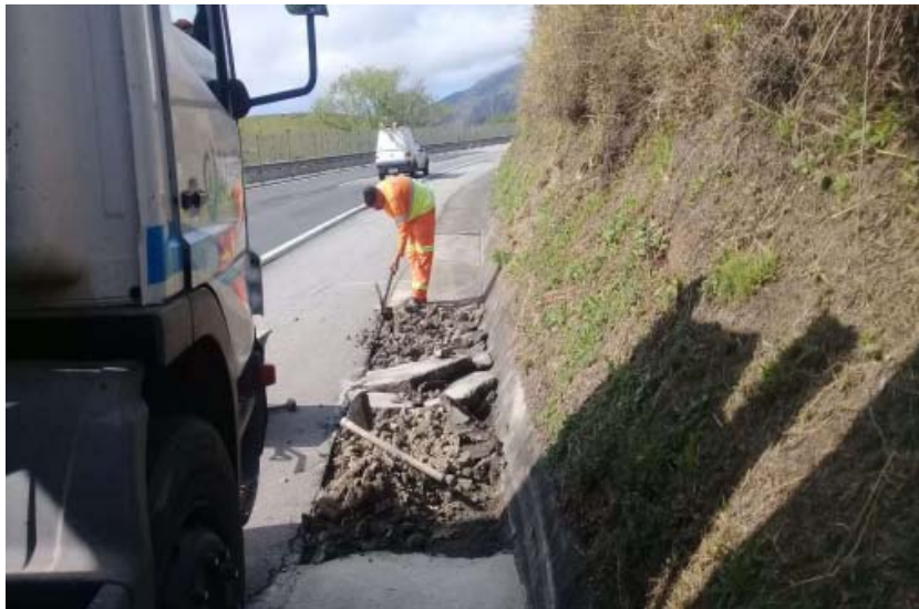
Foto 4 – Recuperação de Sarjeta– Km 08+400 Norte
