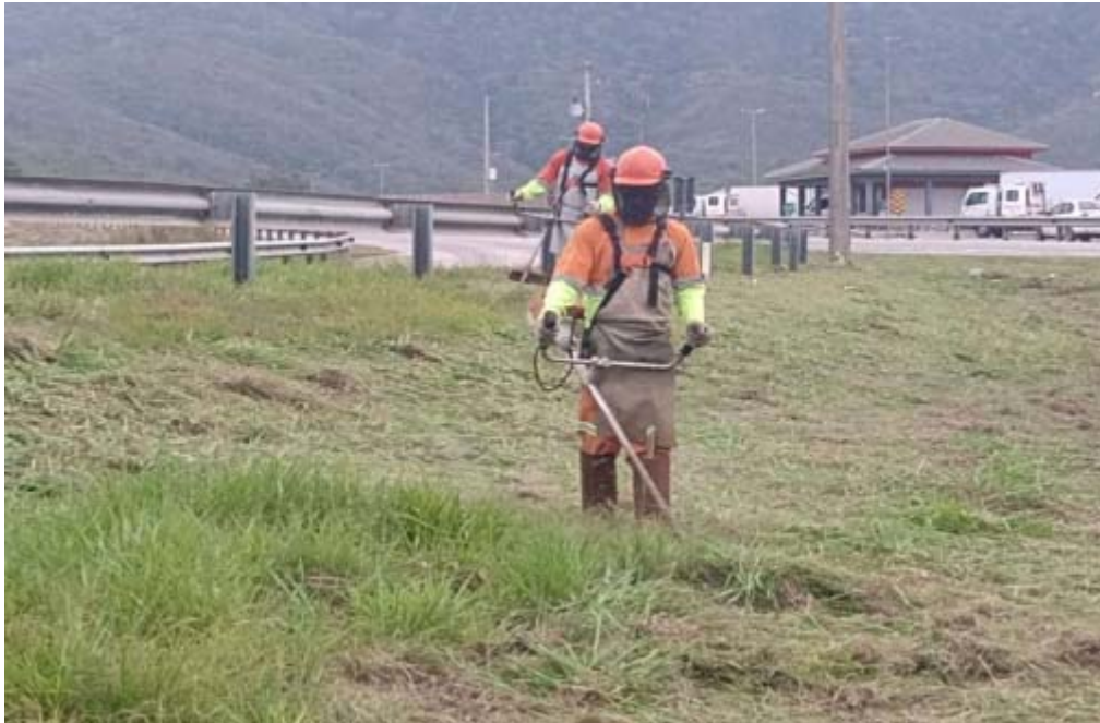
Foto 7 – Roçada Manual – Km 56+800 Norte
