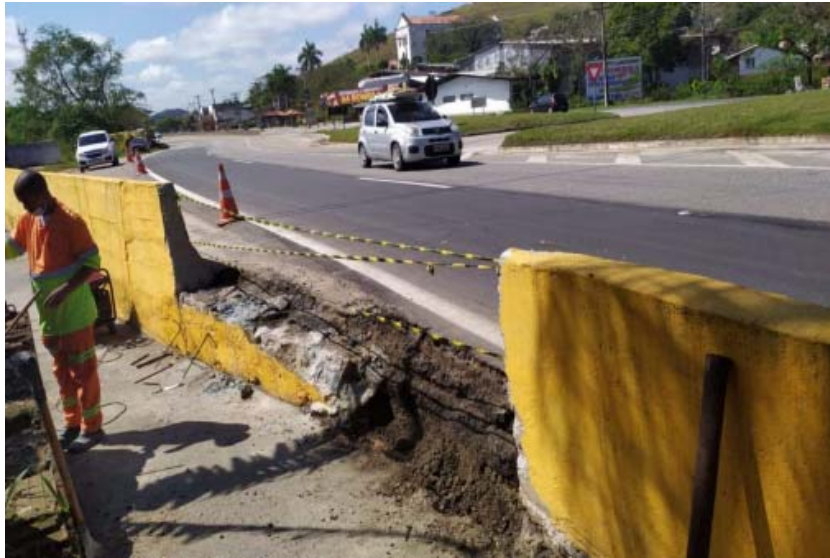
Foto 5 – Reparo na Barreira de Concreto – Km 12+900 Sul [1]
