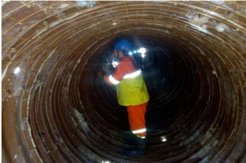
Foto 11 – Ampliação Bueiro – Km 29+320 [2]
