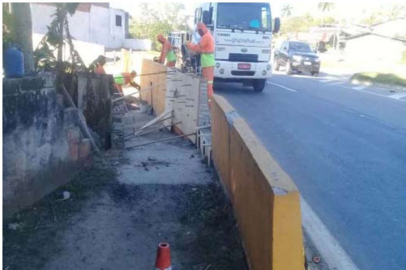
Foto 6 – Reparo na Barreira de Concreto – Km 12+900 Sul [2]
