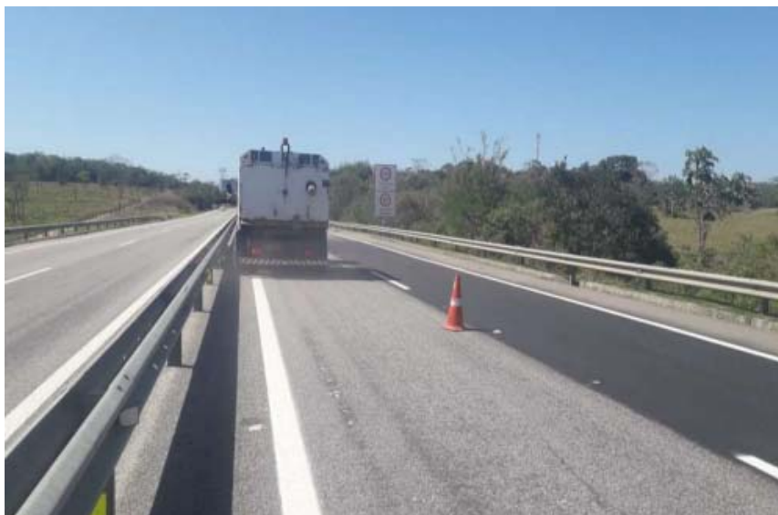
Foto 9 – Varrição da Mediana – Km 27+000 Norte
