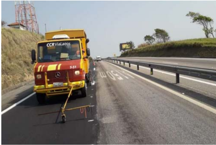
Foto 1 – Pintura de Faixas – Km 44+000 Norte
