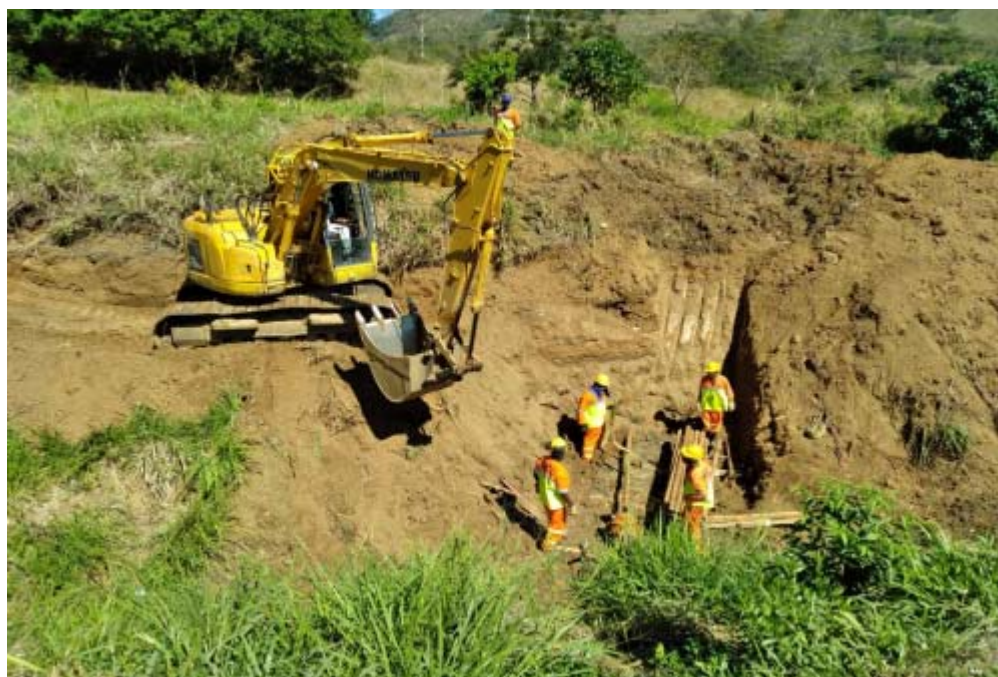
Foto 10 – Ampliação Bueiro – Km 14+900 [1]
