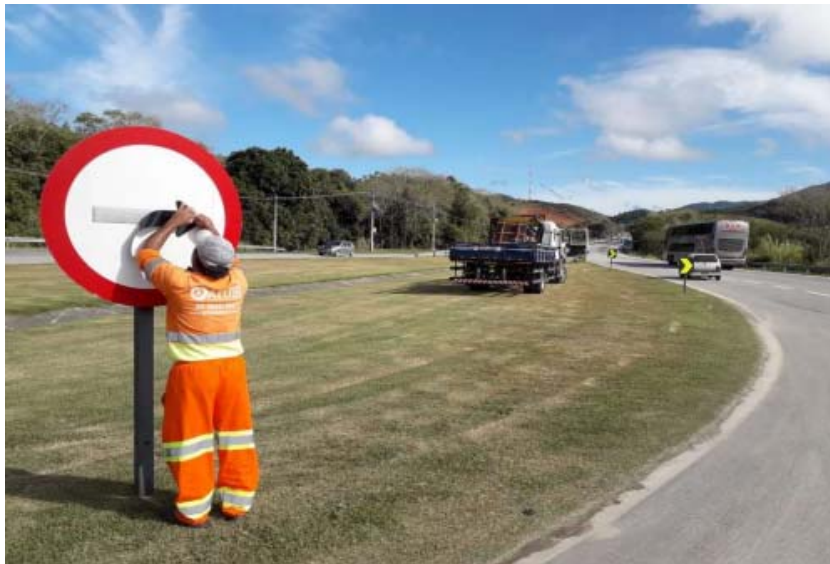
Foto 2 – Reparo de Placa – Km 04+200 Sul
